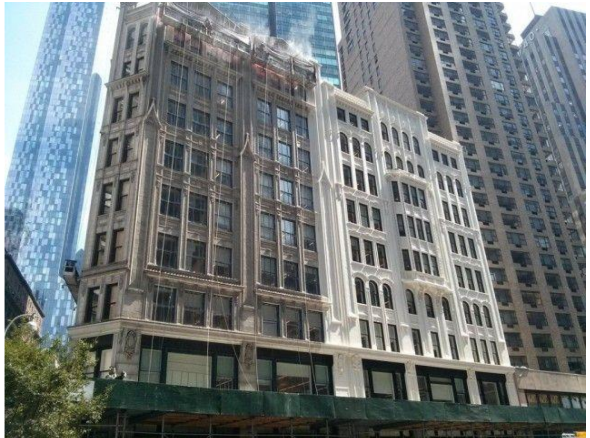
Edificio de apartamentos (Nueva York, E.E.U.U.)
